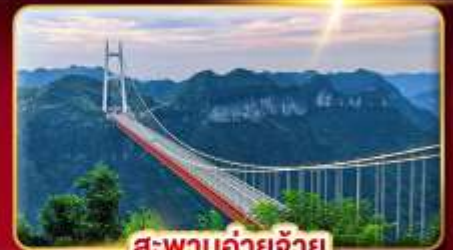
สะพานอ้ายจ้าย
